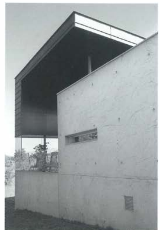
VUE DU PORTE-À-FAUX DE TOITURE ET TERRASSE
